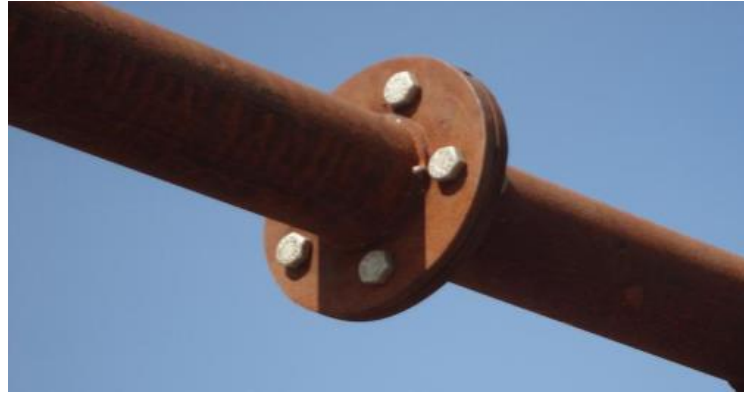
Figura 1: Ligação Flangeada
